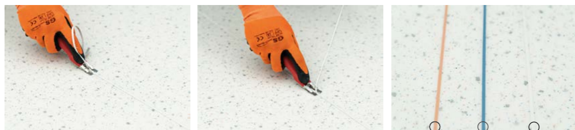
Контрастная сварка Сварка в тон пола
